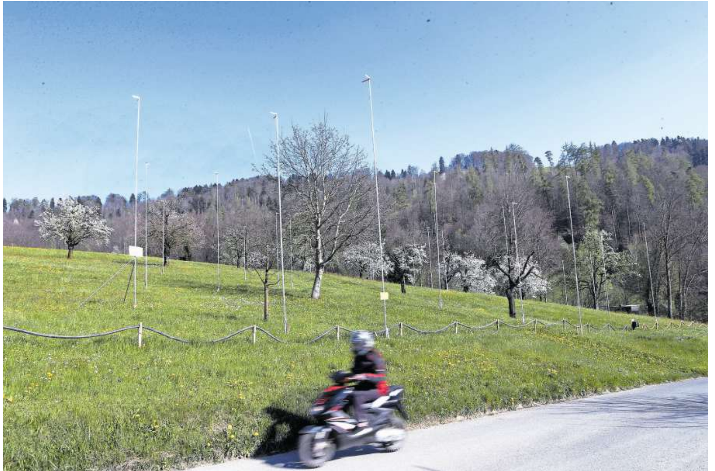
Die Bauprofile oberhalb der Blasenbergstrasse veranschaulichen die Dimensionen der drei geplanten Häuser. Bild: Werner Schelbert (7. April 2017)
