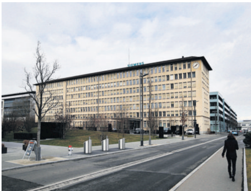
Der Stadtrat soll aufzeigen, wie er die Zukunft des L & G-Gebäudes (im Vordergrund) sieht.
